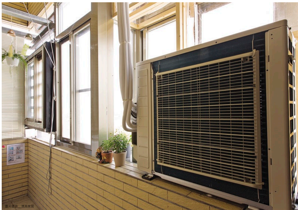
冷氣機應裝在通風良好，不受日光直射的地方，或者裝配遮陽棚。
