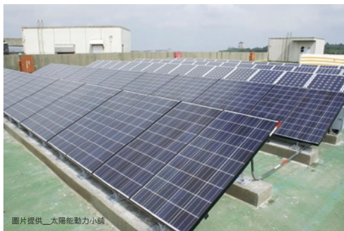
圖片提供_太陽能動力小組 太陽能板可發電又可為屋頂遮陽。
